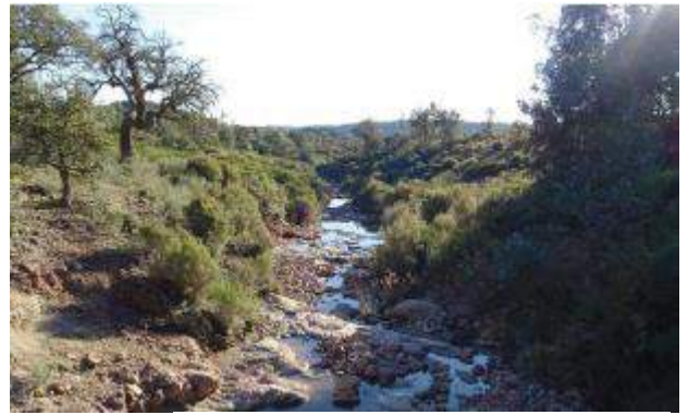
Secteur Barre de Roussivau - Carrefour Castelli
