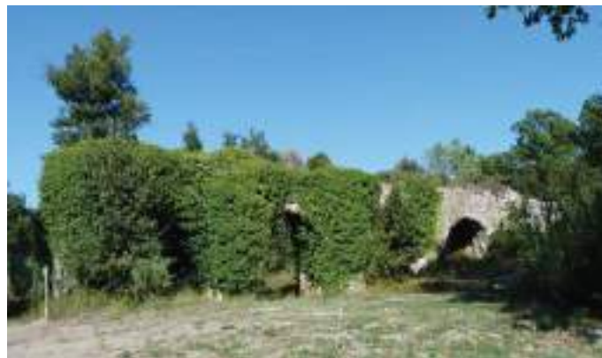
Aqueduc Romain dans la vallée de Reyran
