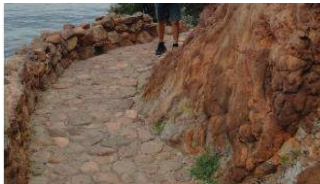
Cheminement et muret en galets rhyolitiques (travail de cantonnier) - Pointe de l'Aiguille - © Agence aps
