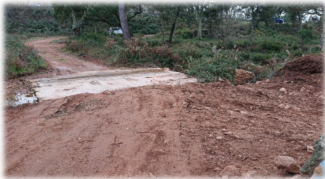
Figure 11 : Réhabilitation gué des Lauriers - commune de Puget-sur-Argens
