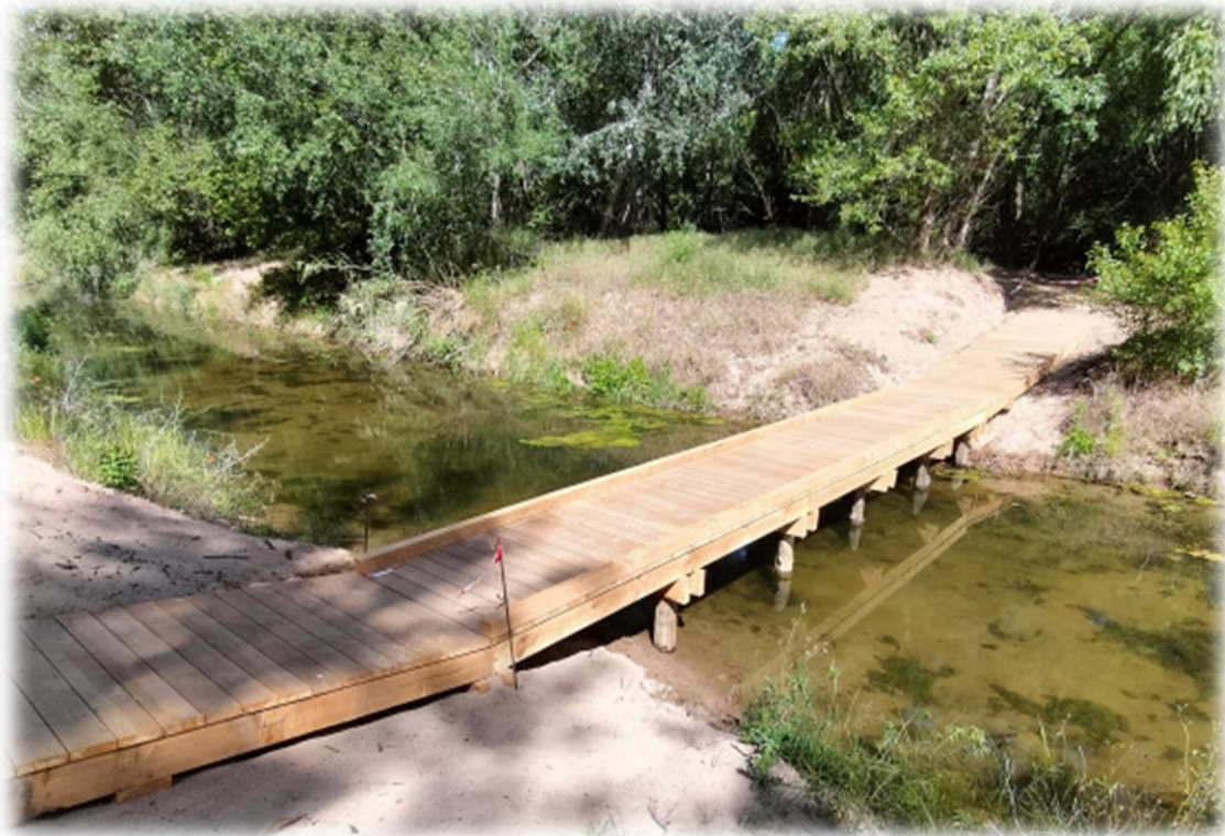
Figure 18 : Passerelle permettant de boucler l'itinéraire du lac de l'Aréna - commune de Roquebrune-sur-Argens
