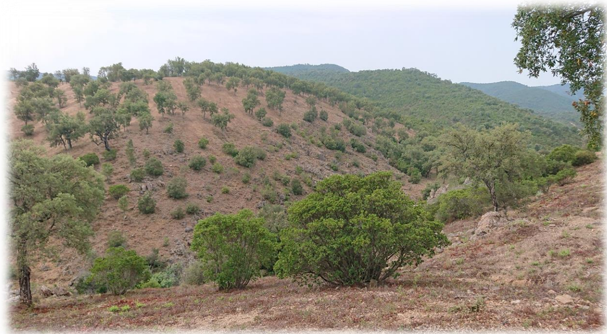
Figure 9 : Débroussaillage piste DFCI F11 Valdingarde – commune de Roquebrune-sur-Argens
