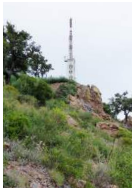
Antenne du pic de l'Ours Source photo : agence aps
