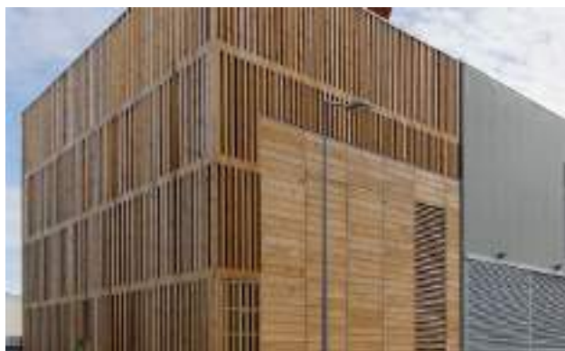
chaufferie biomasse habillage extérieur en pin maritime
