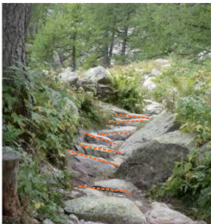
APRES - Création de marches irrégulières, conservation au maximum des pierres existantes. [Source: Photo T.GONELLA - ADAP]
