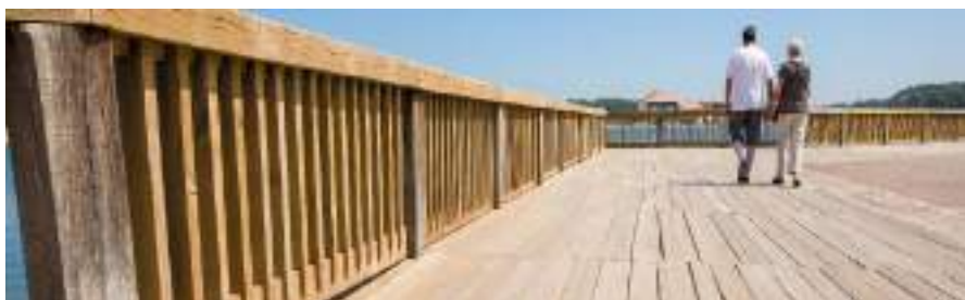
platelage et garde corps en pin maritime - port d'Albret
