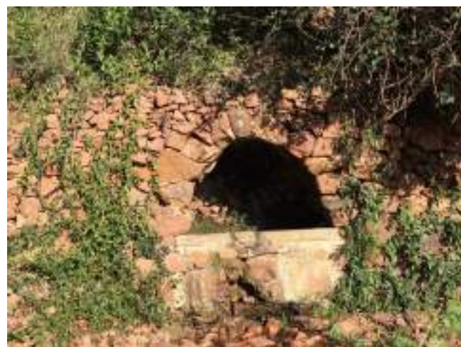
Maçonnerie en appareillage de pierre de site - Massif de l'Estérel
