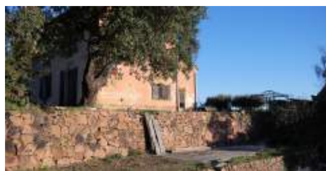
Maçonnerie en appareillage de pierre de site - Massif de l'Estérel
