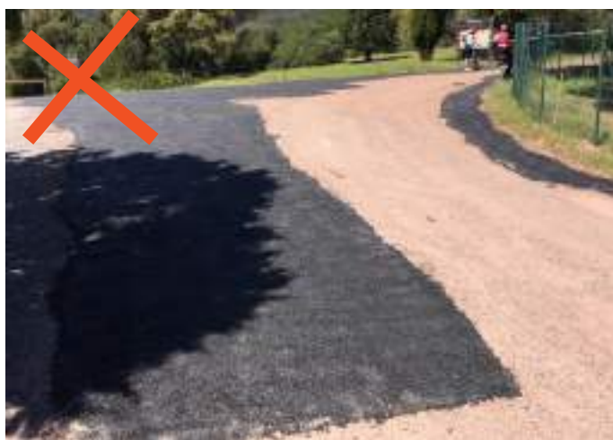
Rustine en enrobé noir (juin 2019) - entrée du site de Roussiveau
