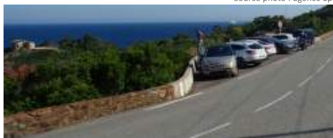
Muret béton accolé au muret de pierre rhyolitique Source photo : agence aps
