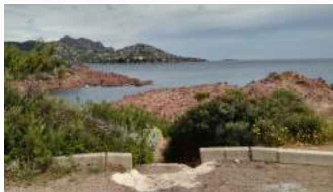
Bordures béton - site du Dramont Source photo : agence aps
