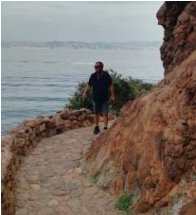
Cheminement et muret en galets rhyolitiques (travail de cantonnier)- Pointe de l'Aiguille Source photo : agence aps
