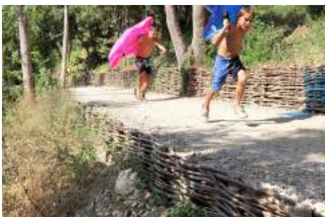
Fascine de bois tressé - Grand Site du Pont du Diable (34)
