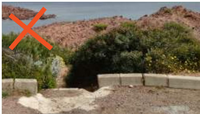
Bordures béton gris - site du Dramont
